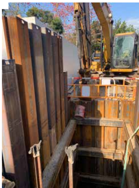
渠務署工程—挖掘工程
